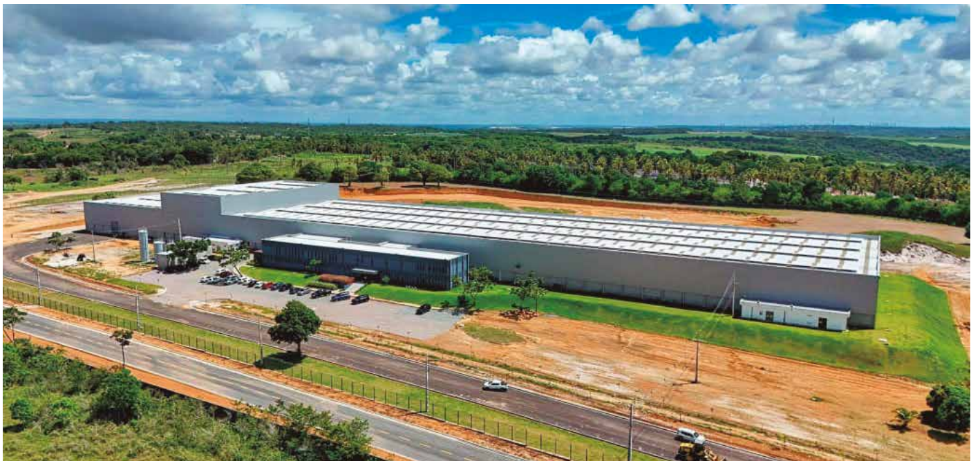
Localizado na Zona Rural, o empreendimento começou a ser construído em 2023 e já gerou 110 empregos diretos na região
